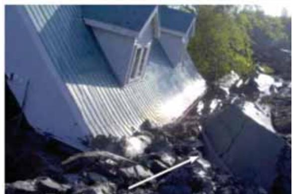
**Figure I-13:** Destruction d'une résidence lors du glissement de terrain à Saint-Jude en 2010 (Locat *et al.*, 2011).
