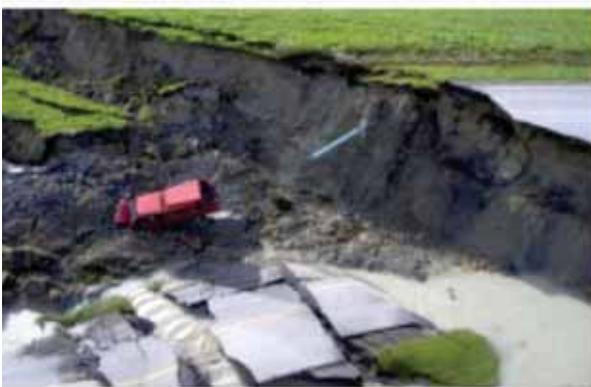
**Figure I-12:** Destruction de la route à la suite du glissement de terrain à Saint-Jude en 2010 (Locat *et al.*, 2011).
